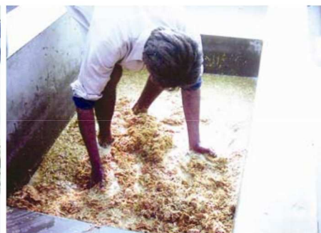
Figura 8, 9. Agregar la paja de trigo empapada a la solución de piedra de cal
