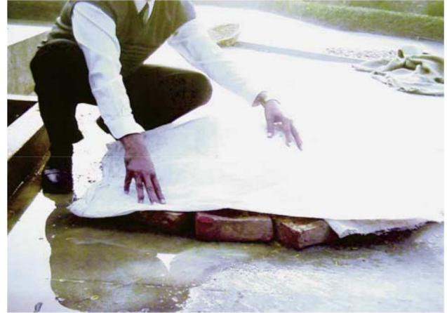
Figura 17, 18. Cubrir el sustrato con una hoja de plástico para mantener el calor, el gas y la humedad
